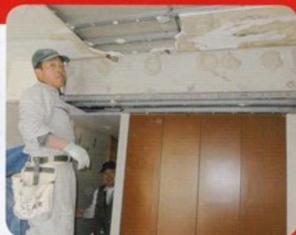
〈内装工事の様子です。〉
