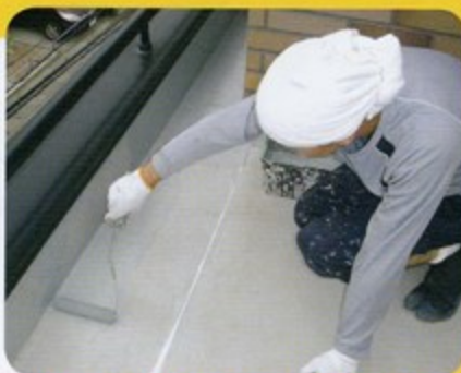
〈ベランダの防水工事の様子です。〉
