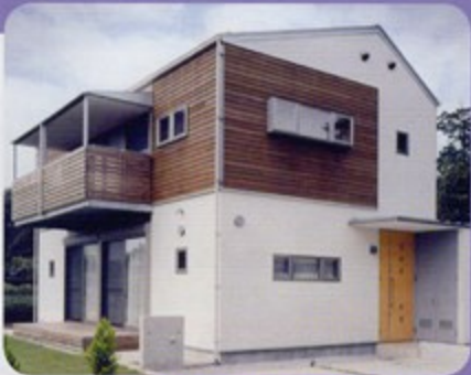
〈注文住宅の施工例です。〉
