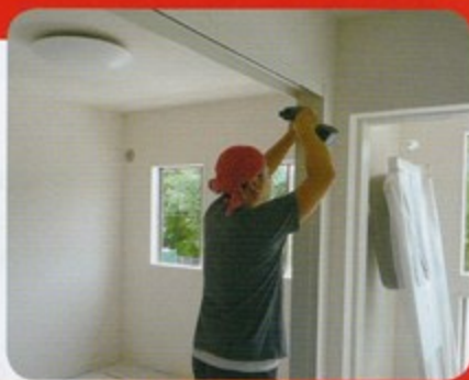
〈内装工事の様子です。〉
