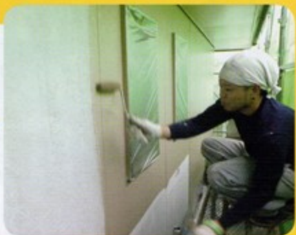
〈塗装作業の様子です。〉
