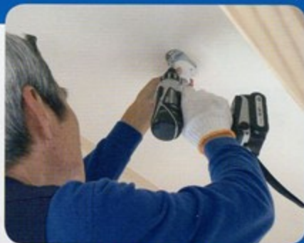
〈照明取付工事件業の様子です。〉
